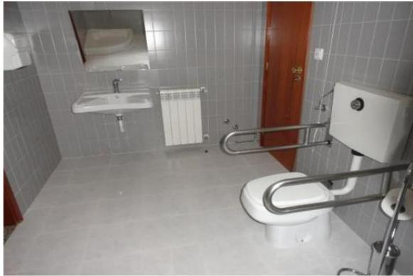
Fig. 26. Sanitário para Mobilidade Condicionada
