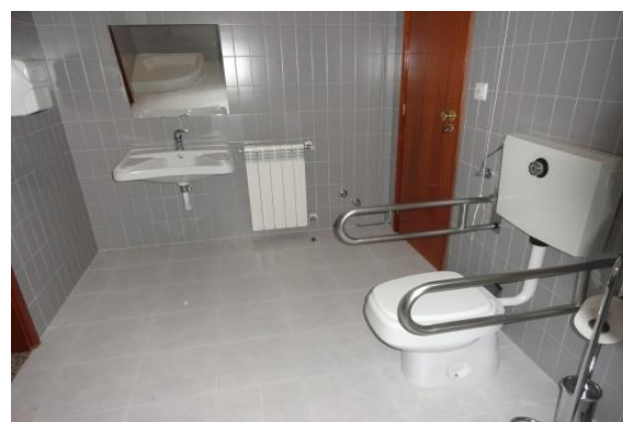
Sanitário mobil. condicionada
